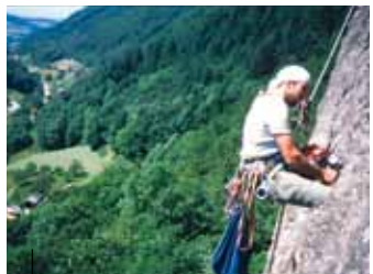
Sanierung der Sicherungshaken
