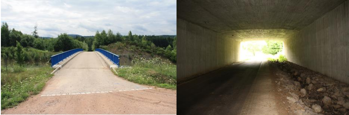
Abbildung 43: Links: Asphaltierte Wirtschaftswegeüberführung bei Murg über die A 98. Rechts: Die Wirtschaftswegunterführung bei Murg (A 98).
