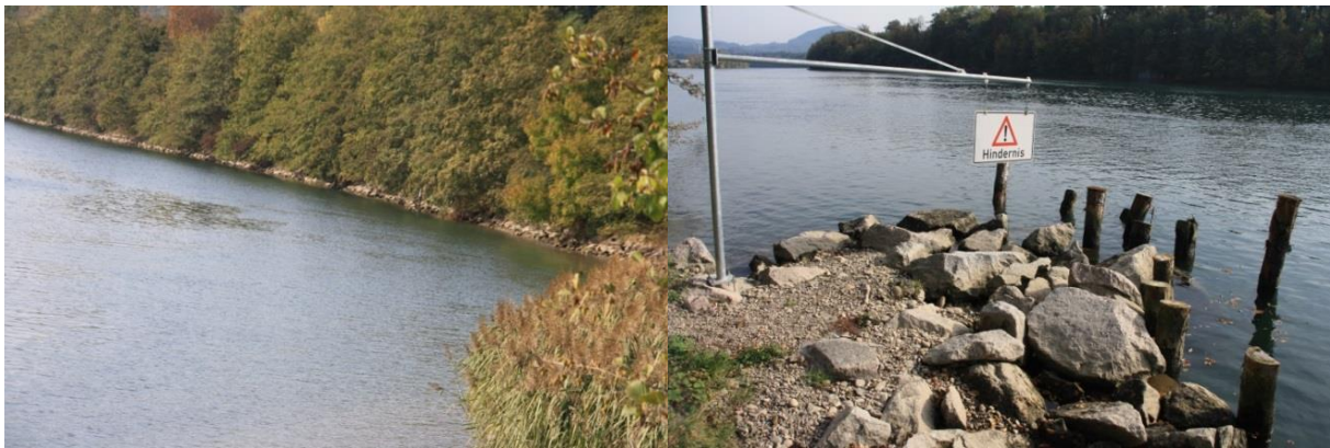
Abbildung 42: Uferbefestigung mit Blockhalden im Teilgebiet U4 (links). Steinbühne zur Beeinflussung der Strömungsverhältnisse beim Rheinkilometer 126 (rechts).
